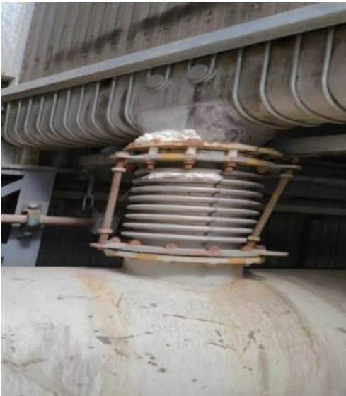
图5 出水柱壁温测点安装位置
